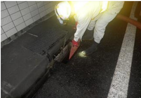
<トンネル円形水路清掃>
