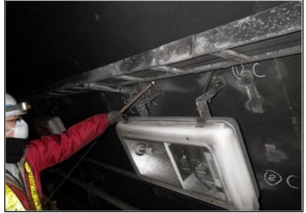
<トンネル照明点検>
