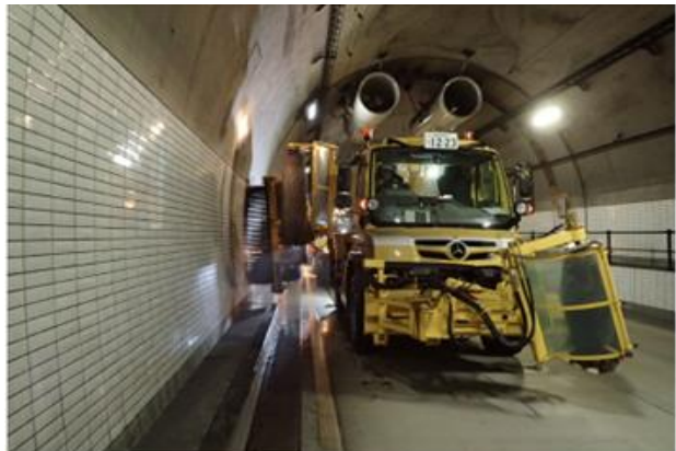
<トンネル側壁清掃>
